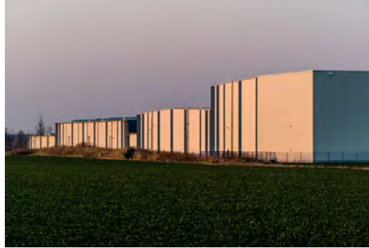
Sonderbauten – Industriebauten: Hallen in Kremmen
