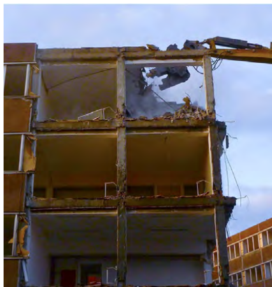
Gebäudeabbruch in Potsdam
