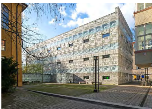
Sonderbau: Hochschulbibliothek Eberswalde
