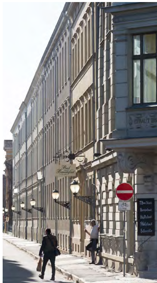
Beispiel Gebäudeklasse 4: Potsdam, Zimmerstraße
