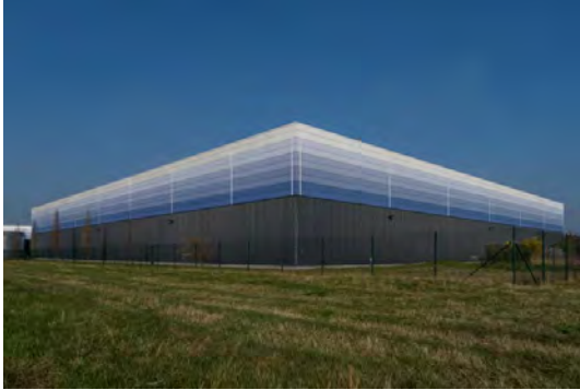
Sonderbauten – Industriebauten: Magna Park Werder (Havel)
